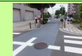
遮熱性すず風舗装
