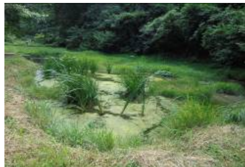
平成 29 年 8 月の沈砂池
