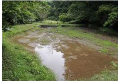
平成 28 年 6 月の沈砂池
