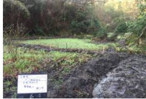
さらに上流部の沈砂池
