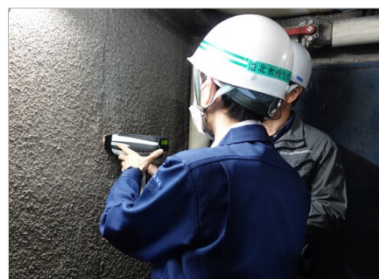
アスベストアナライザーを用いて 建材測定を行っている様子
