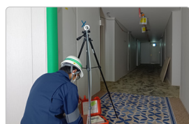
浮遊アスベスト濃度の測定
