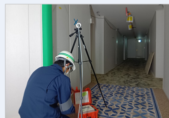
図 4-26 浮遊アスベスト濃度の測定
