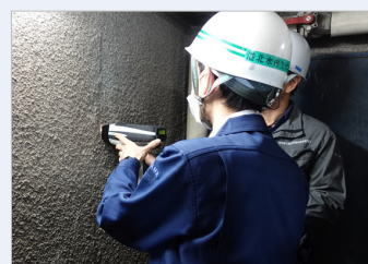
図 4-33 ASA との災害対応訓練（アスベスト調査）
