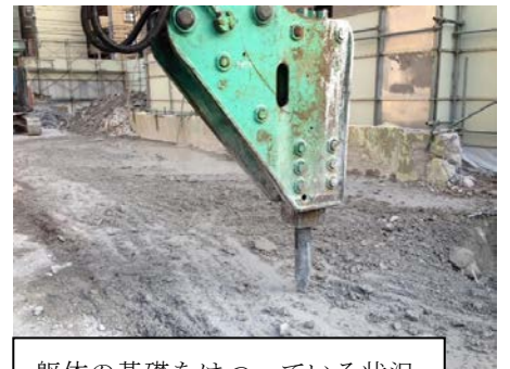
躯体の基礎をはつっている状況
