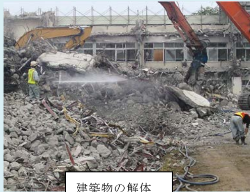
建築物の解体
