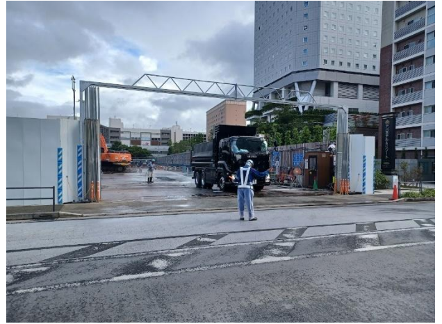
写真 3.3-2 タイヤ洗浄の様子
