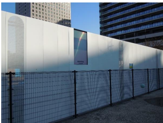
写真 3. 2-6 仮囲いの設置状況
