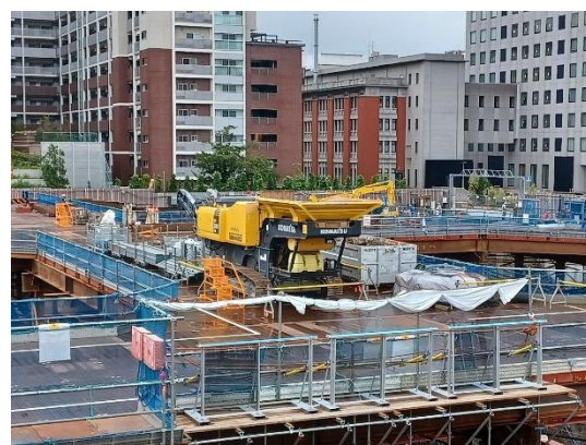
写真 3. 1-6 柱状改良資材の破碎状況
