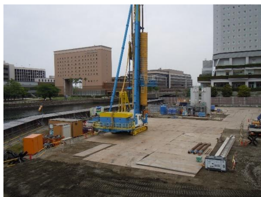
写真 3.5-1 敷鉄板の設置状況
