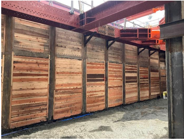
写真 3.3-1 止水壁の使用状況
