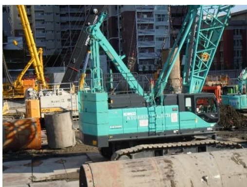
写真 3. 4-2 低騒音型建設機械の使用状況
