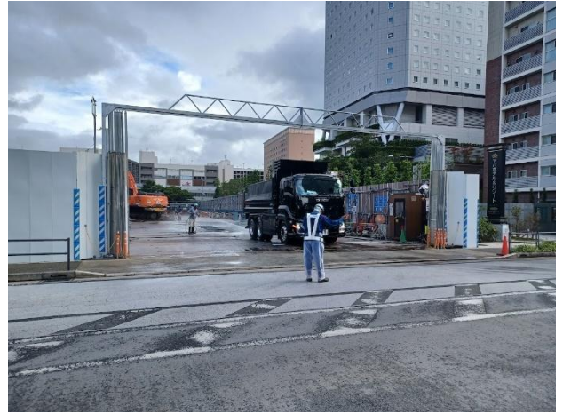
写真 3.3-2 タイヤ洗浄の様子
