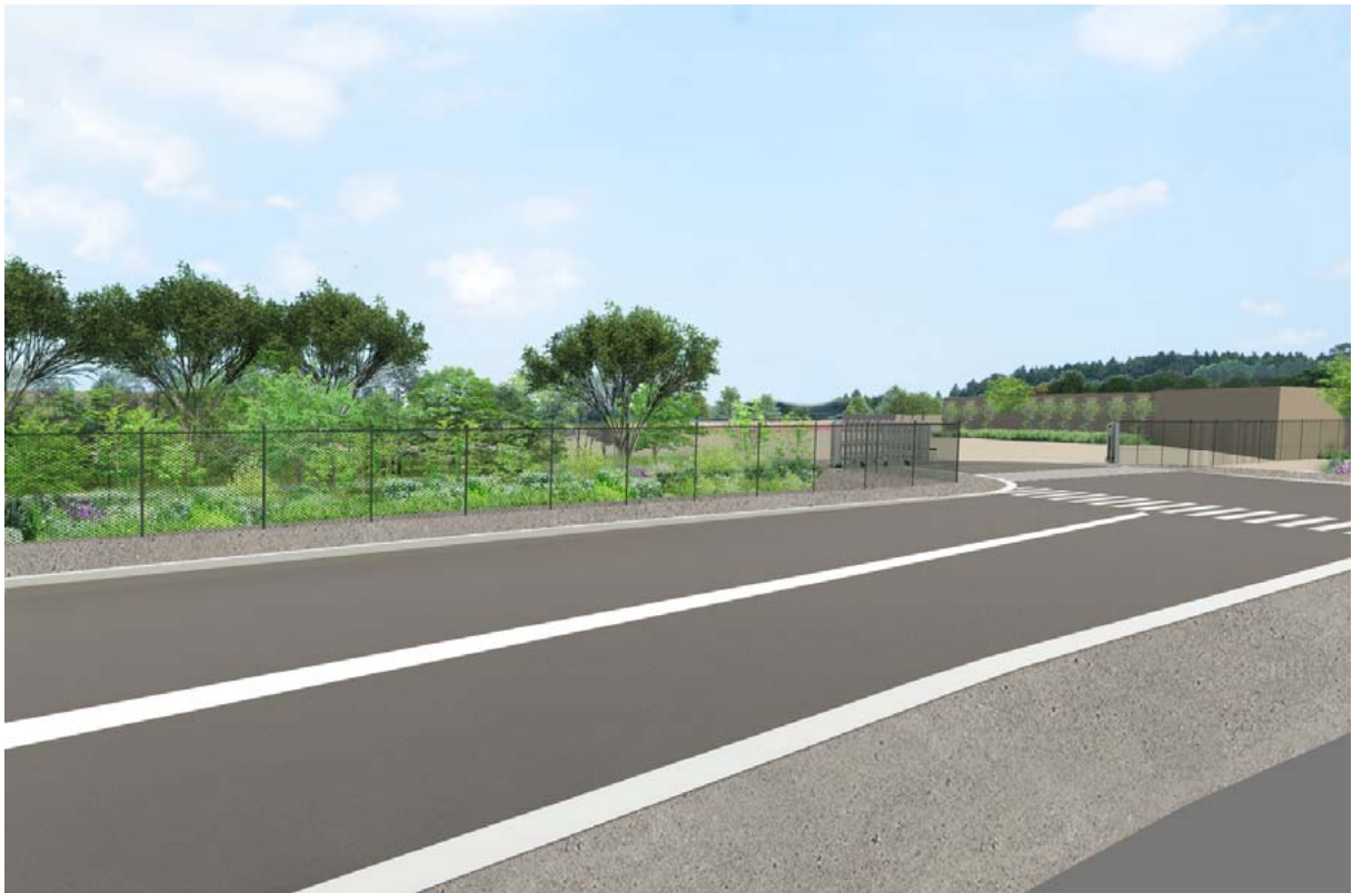
写真 6.11-4(3) No.22 旧上瀬谷通信施設内通路(対象事業実施区域 南側) (開催中)
