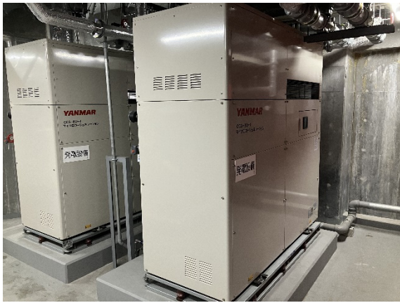
写真 3.4-1 高効率機器(マイクロコージェネレーション)
