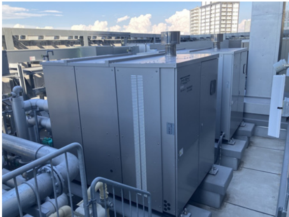
写真 3.4-3 高効率機器(冷温水器)
