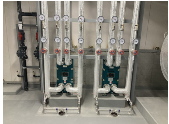
写真 3.4-4 高効率機器(プレート式熱交換器)
