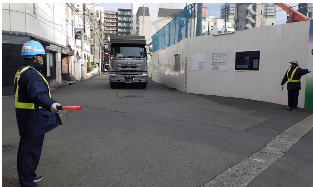
写真 3.3-3 誘導員の配置状況 (2)
