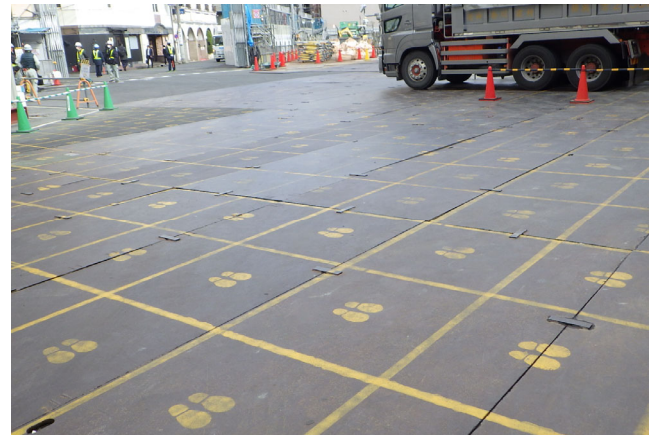
写真 3.2-2 段差のない鉄板敷の設置状況
