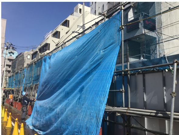
写真 3.1-9 仮囲い上部の飛散防止カーテン
