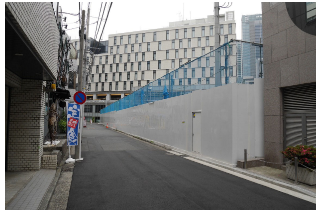
写真 3.1-8 仮囲いの設置状況
