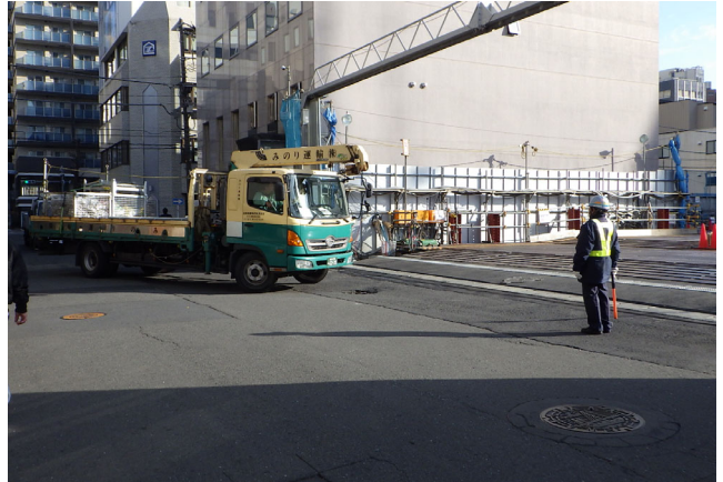
写真 3.3-2 誘導員の配置状況 (1)
