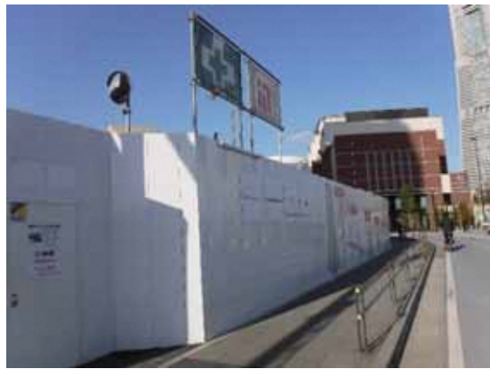
写真 3.3.1-7 仮囲いの状況
