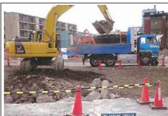
写真 3.3.3-1 搬出車両への積み込み
