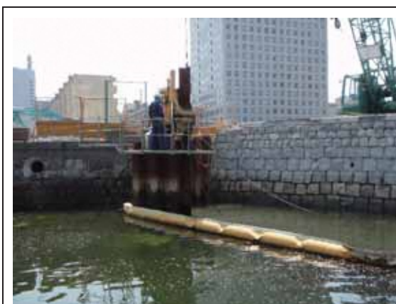
写真 3.3.7-1 濁水防止フェンスの状況
