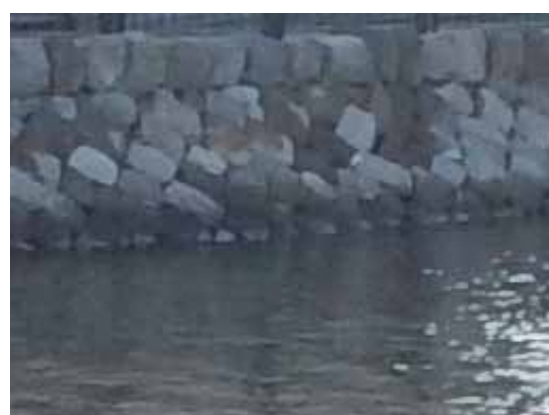
写真 3.3.7-3 既存の石を積極的に再利用した石積護岸
