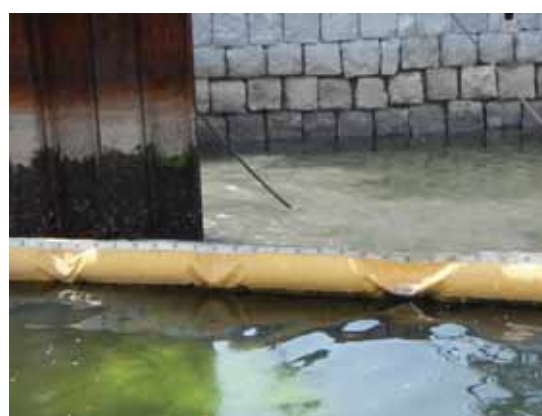
写真 3.3.7-2 濁りの拡散防止の状況
