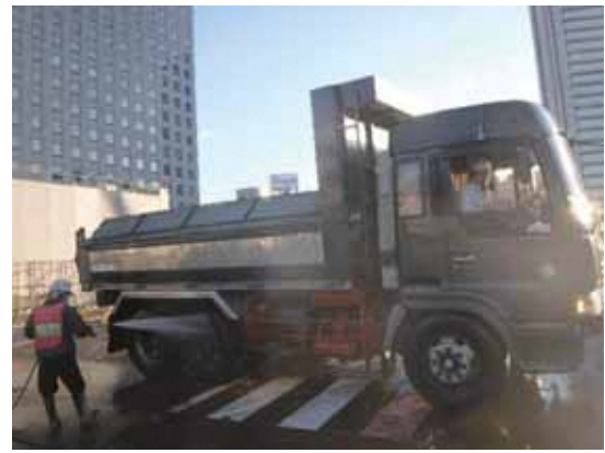
写真 3.3.1-6 タイヤ洗浄の状況
