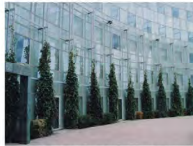
建物デザインと調和した軽快な素材の誘因施設によるカーテンウォールの緑化（パリ市）
