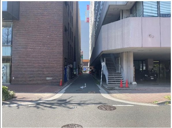
⑥ 市道山下町9号線 東側より
