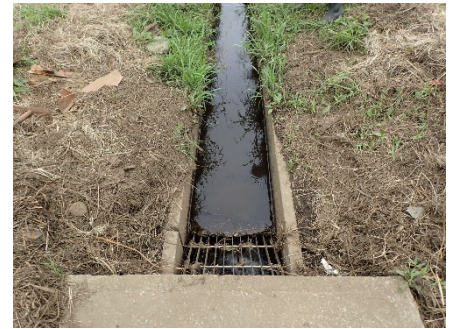
図 5-4 st-4（側溝）の状況
