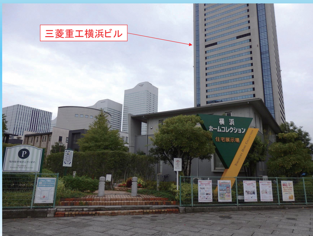
計画区域北西側より撮影(平成30年9月3日撮影)
