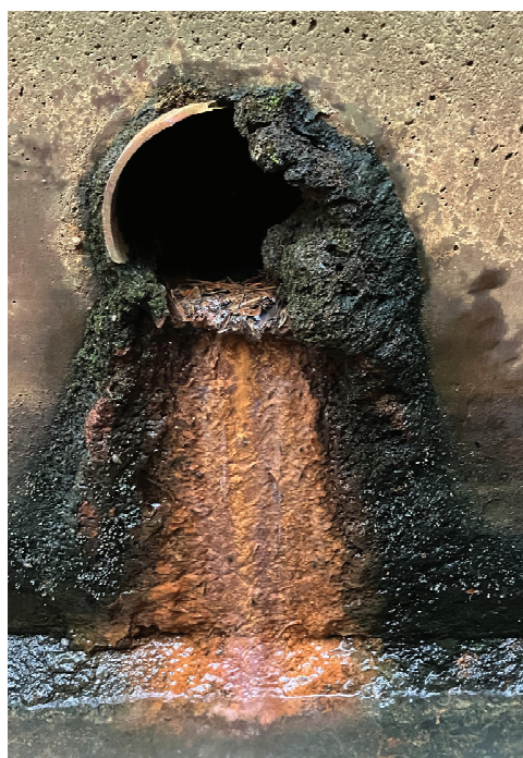
図 18-3 (2) 西側の透水管と河川（水路）の接続部で確認した排水口（近景） （撮影：令和 8 年 5 月 20 日）
