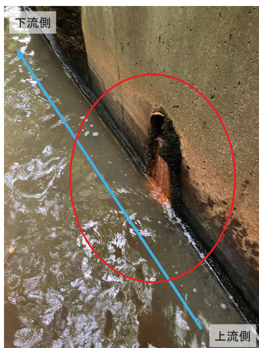
図 18-3 (1) 西側の透水管と河川（水路）の接続部で確認した排水口 （撮影：令和 8 年 5 月 20 日）
