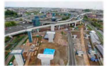
交通ネットワークの形成 横浜環状北西線横浜青葉ＩＣ・ ＪＣＴ（仮称）（青葉区）
