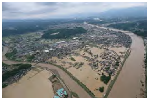
写真2-1-1 令和2年7月豪雨の被害の様子
