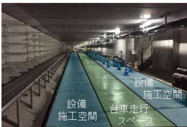
図5－12 タイヤ式台車使用による同時施工イメージ
