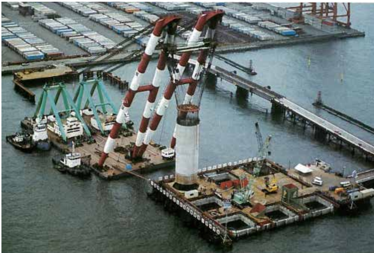
写真３－１ 3,000 tフローティングクレーンによるプレキャストケーソン吊込み 出典：よこはまの道路 1986（道路局）
