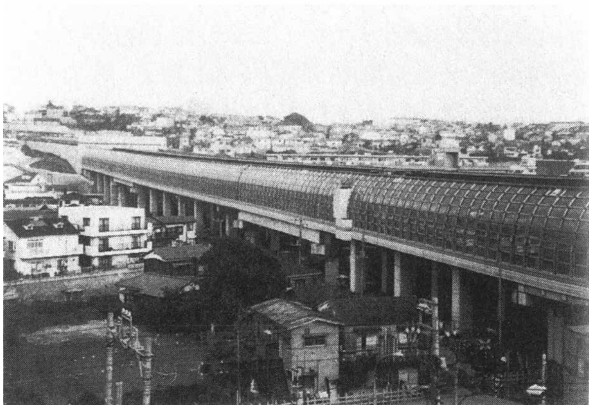
避音壁およびルーバー設置状況(保土ヶ谷高架橋を東京方向へ望む)
