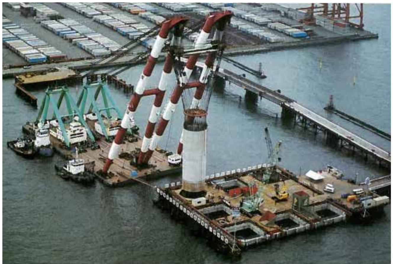
写真3-1 3,000 t フローティングクレーンによるプレキャストケーソン吊込み
