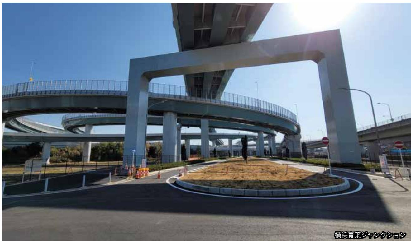
横浜環状北西線（以下「北西線」という。）は、第三京浜道路港北インターチェンジから東名高速道路横浜青葉インターチェンジに至る区間で、北線と一体となって横浜市の湾岸エリアと東名高速道路の沿線エリアを直接結ぶ路線である。延長は約7.1km。うち、トンネル部が約4.1km、往復4車線の自動車専用道路である。
