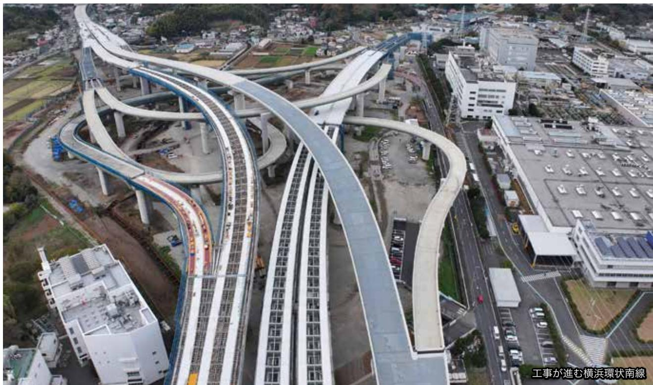
横浜環状南線は横浜環状道路の南側区間で、金沢区釜利谷町の釜利谷ジャンクションを起点に戸塚区原宿町で国道1号に接続する延長約8.9kmの自動車専用道路である。
