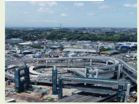
⑫横浜港北JCT付近上部工架設の状況
