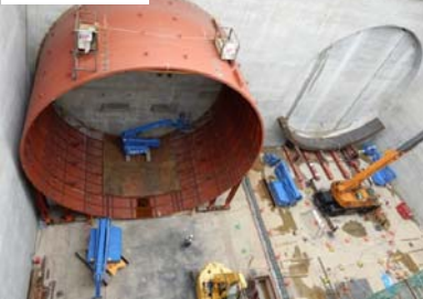
⑨到達立坑内部
