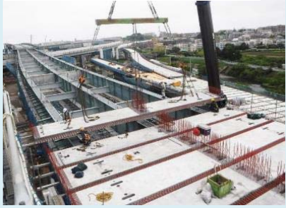
③床版架設状況（現時点ではすべて完了）
