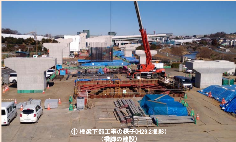
青葉区下谷本町の施工状況
