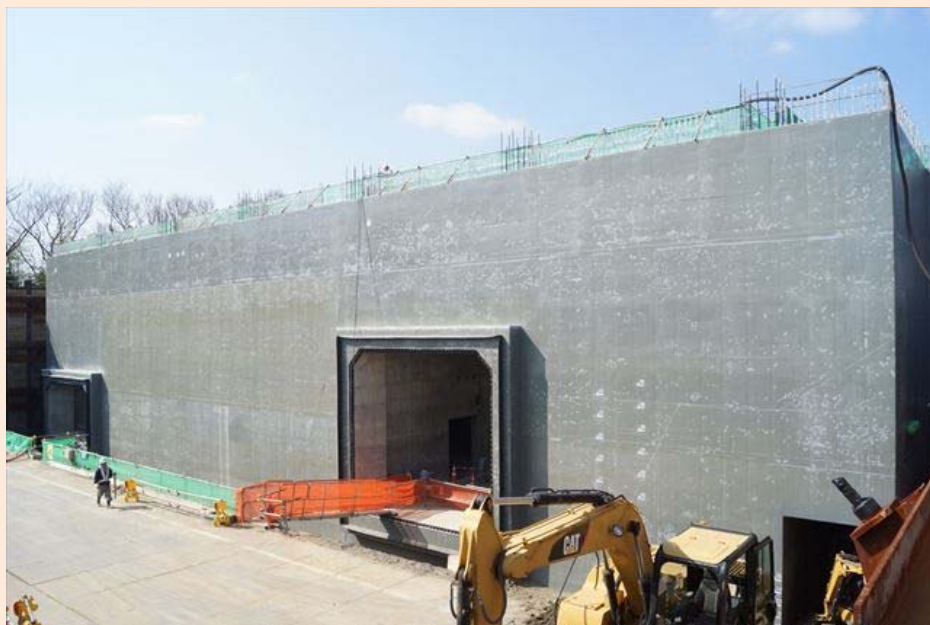
⑤(仮称)東方換気所の様子 (H29.2撮影) (換気所地下部分)
