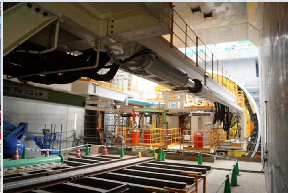
③ 発進立坑の様子(H29.2撮影) (シールドマシンまでセグメントを運ぶ後続台車)
