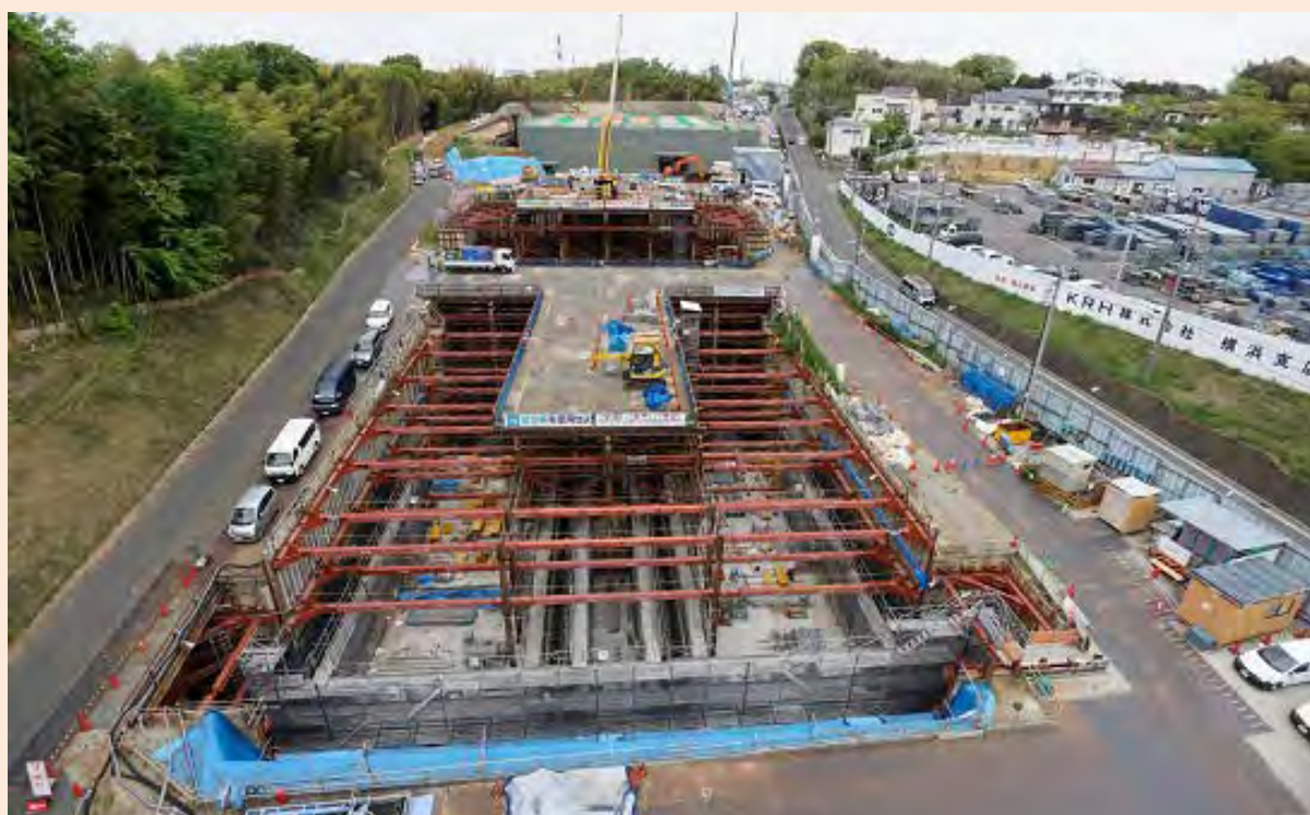
④ シールドマシン到達立坑付近の様子 (H29.4撮影)
