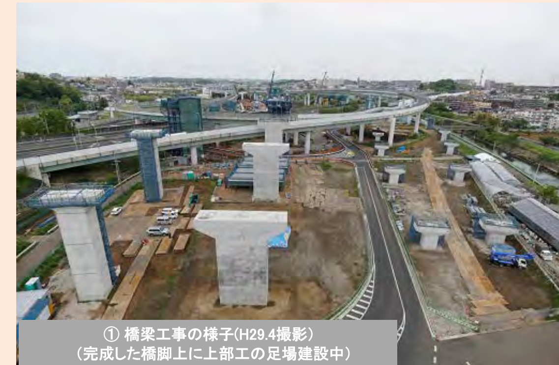
青葉区下谷本町の施工状況
