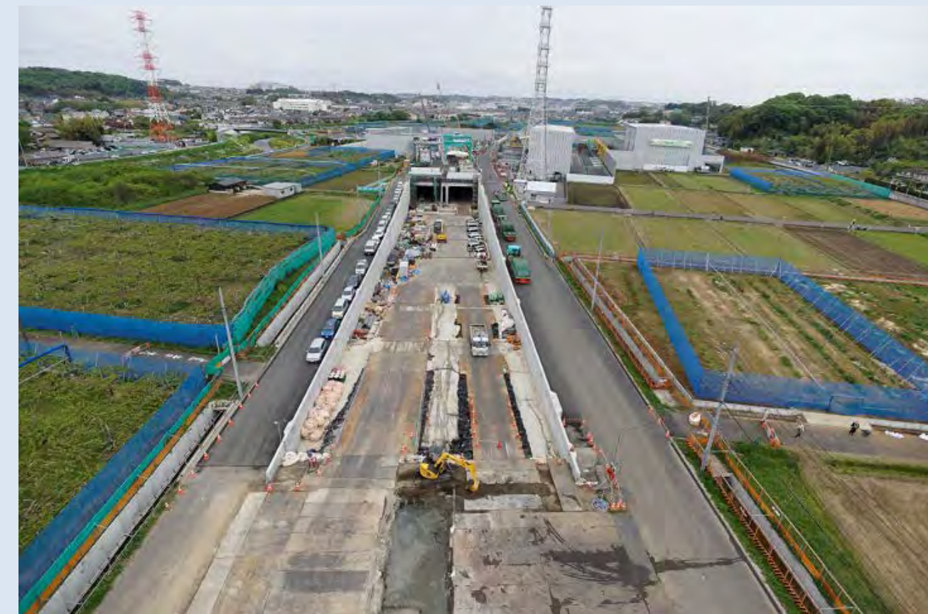
② U型擁壁・開削トンネル周辺の様子(H29.4撮影)
