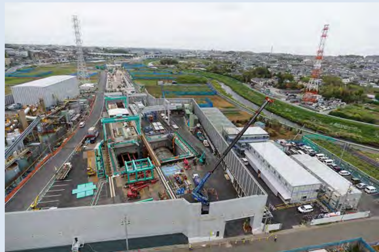
③ 発進立坑周辺の様子(H29.4撮影) (②写真の反対方向から撮影)
