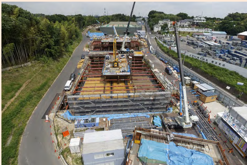
④ 到達立坑及び換気所建設の様子 (H29.6撮影)
