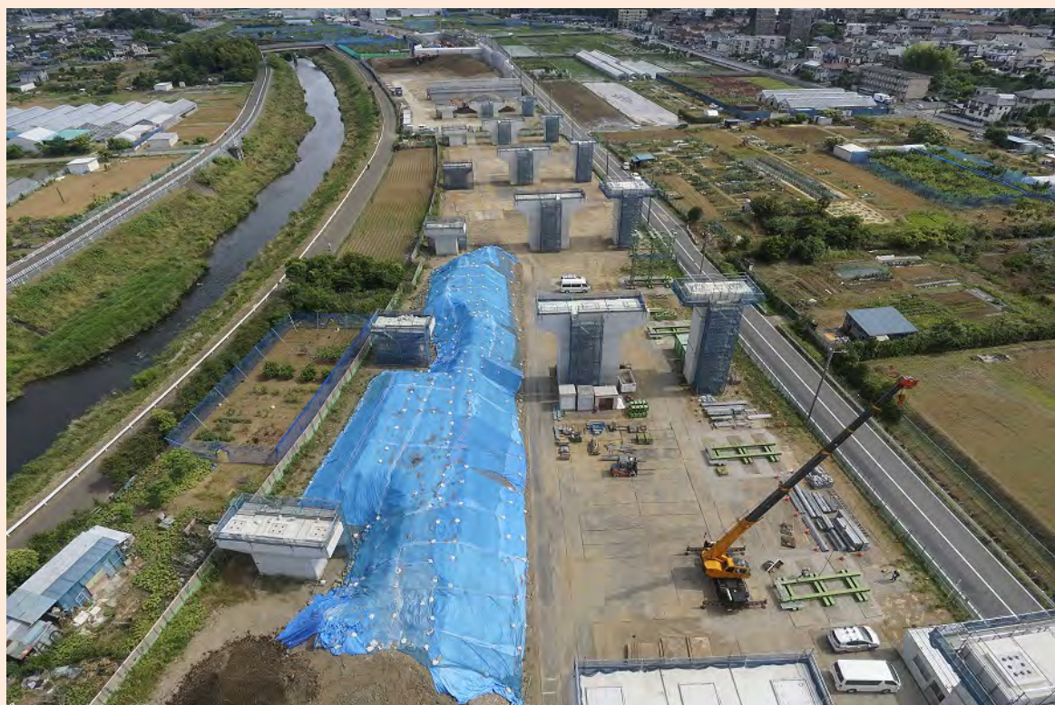
② 橋梁工事の様子(H29.6撮影) (①の反対側を撮影)
