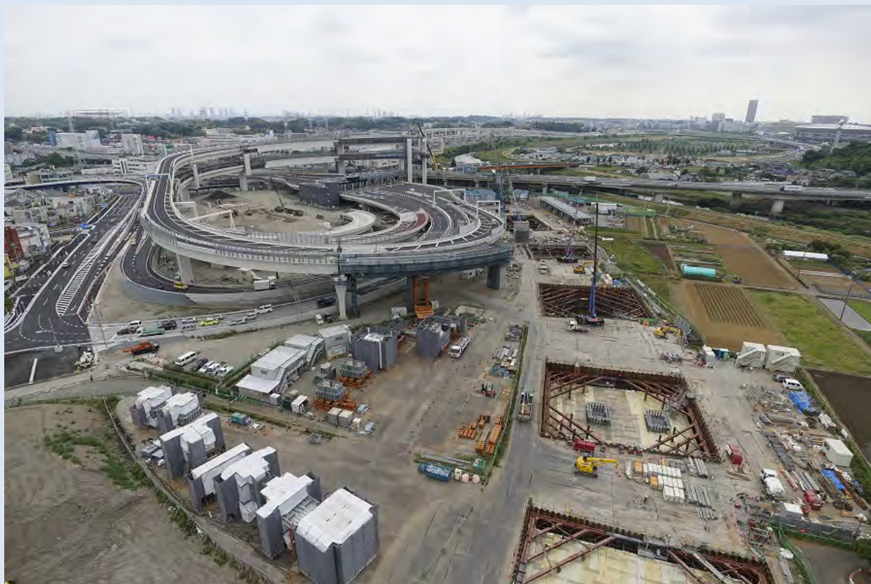
⑤横浜港北JCT付近の橋脚建設の様子 (H29.6撮影)
