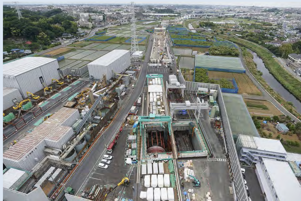
③ 発進立坑周辺の様子(H29.6撮影)
