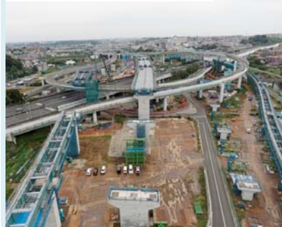
②横浜青葉IC・JCT付近の架設状況
