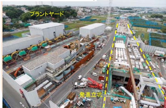
④全景 (プラントヤード・発進立坑)
