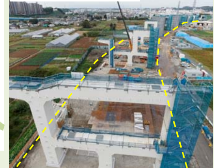
⑪横浜港北JCT付近上部工架設 (10/14第三京浜通行止め) ※首都高施工区間
