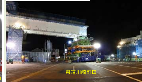
⑪県道川崎町田上部工架設 (H30.1.13・1.20 通行止め)
