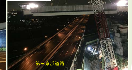
⑫横浜港北JCT付近上部工架設 (H29.10.14第三京浜通行止め) ※首都高施工区間
