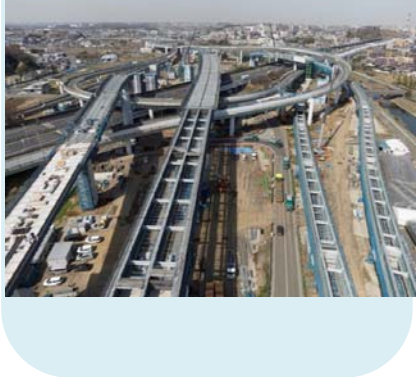
②横浜青葉IC・JCT付近の架設状況
