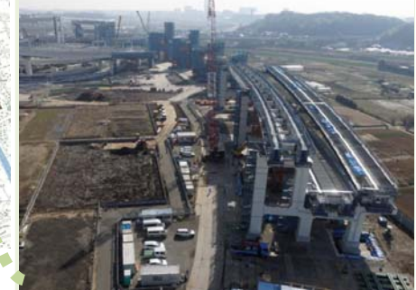
⑩鋼製橋脚及び架設の状況
