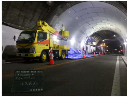
目地処理・裏込材注入
