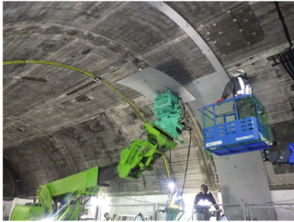
内巻鋼板設置
