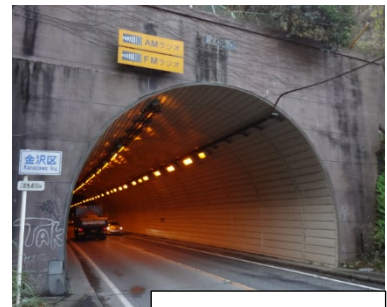
坑口部(栄区側)
