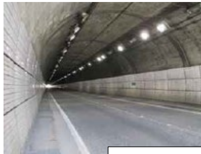
トンネル内部
