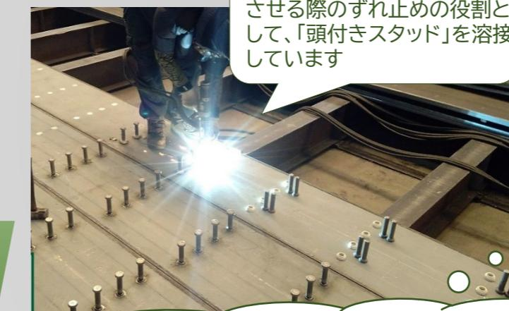
鋼桁とコンクリートを一体化
