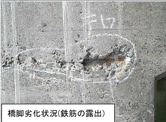
橋脚劣化状況(鉄筋の露出)
