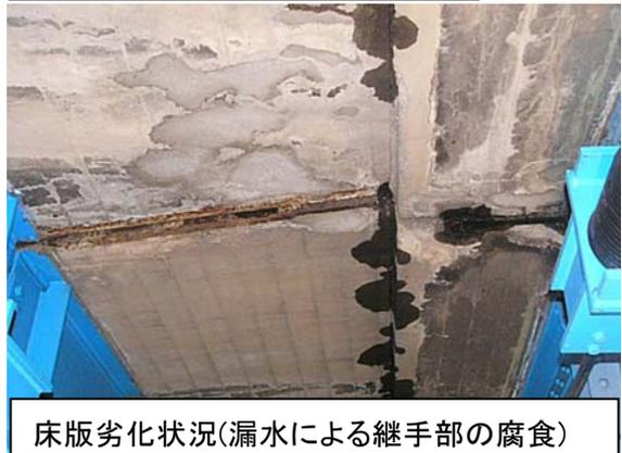
床版劣化状況(漏水による継手部の腐食)
