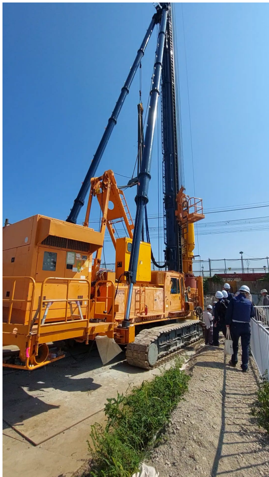
重機 移動状況
