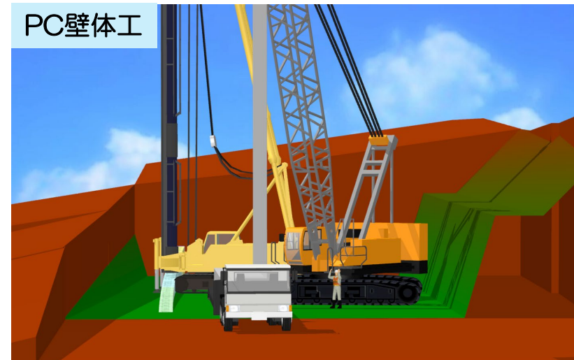
壁となる杭を地中に入れ込みます。
