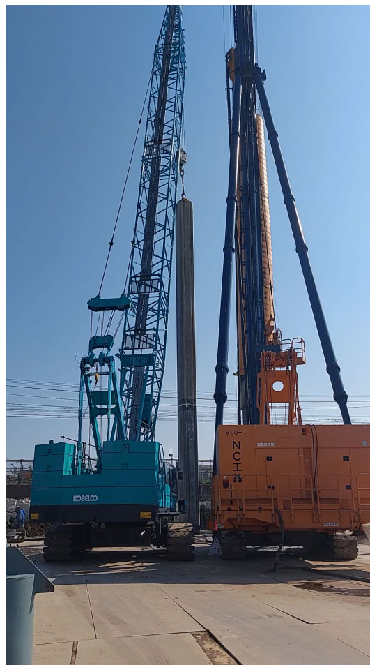
壁体杭 沈設状況
