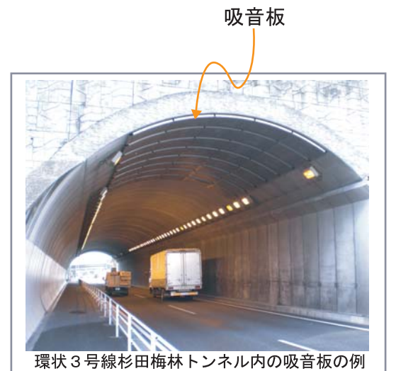
環状3号線杉田梅林トンネル内の吸音板の例
