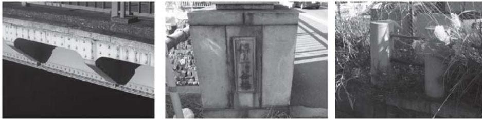
保土ヶ谷橋の現況
