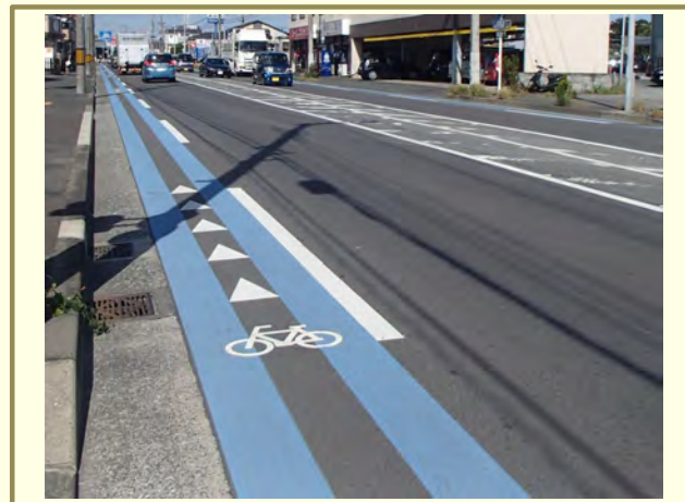
R3整備箇所(上飯田交番前交差点付近)
