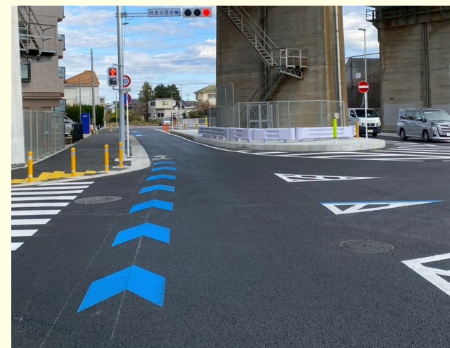
R7 整備箇所
