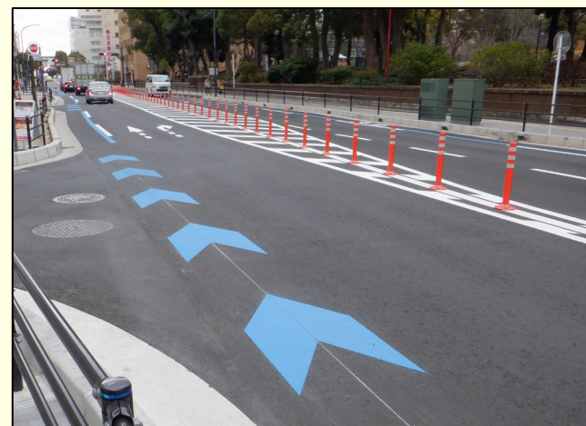
R7 整備箇所
