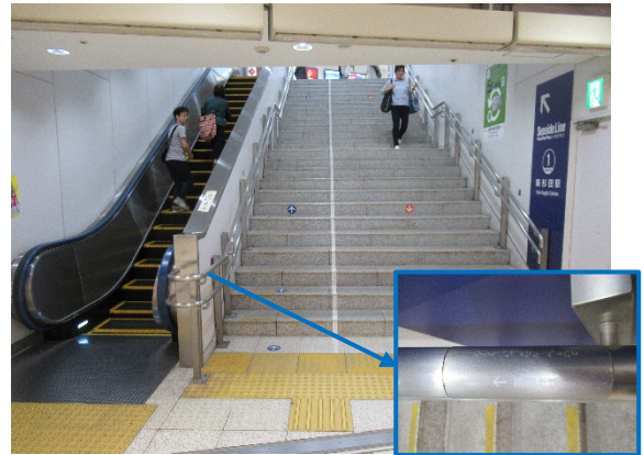
[シーサイドライン新杉田駅] ・手すりの改善（点字の設置、端部の延長）
