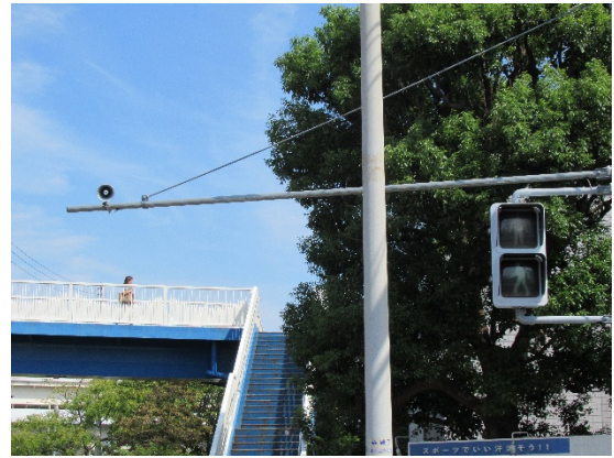
[新境橋交差点] ・音響式信号機等の設置
