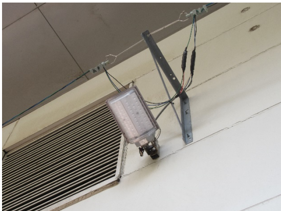
[経路⑤ (アルカード新杉田駅東側)]
