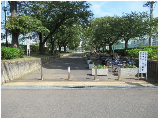
[新杉田公園] • 移動等円滑化された出入口への改善
