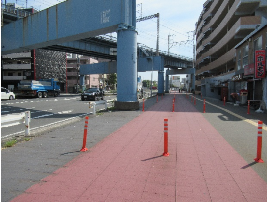
[経路⑦-2 (磯子産業道路)] ・車止めの移設
