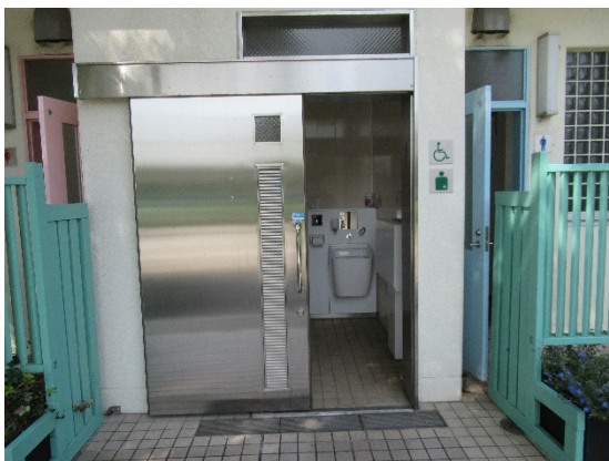
[新杉田公園] • オストメイトに対応した水洗器具の設置
