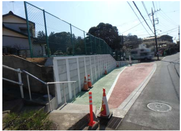
状況写真(実施後)
