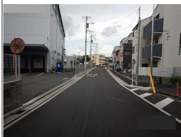
状況写真(実施後)
