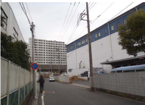
状況写真(実施前)
