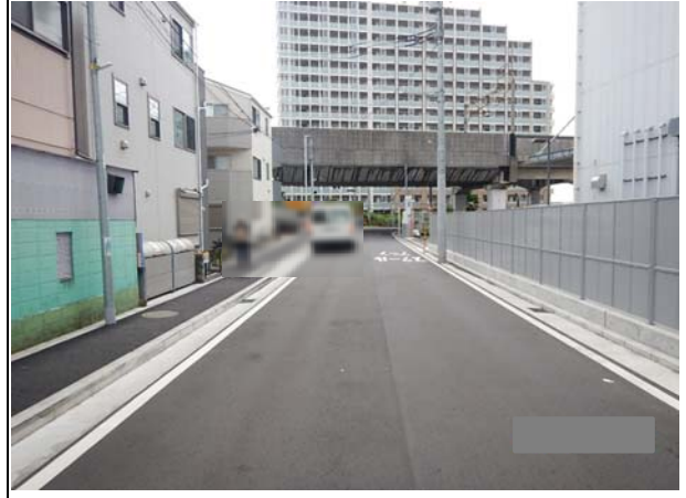
状況写真(実施後)
