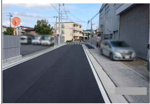
状況写真(実施後)
