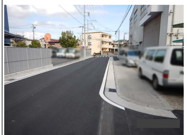
状況写真(実施後)
