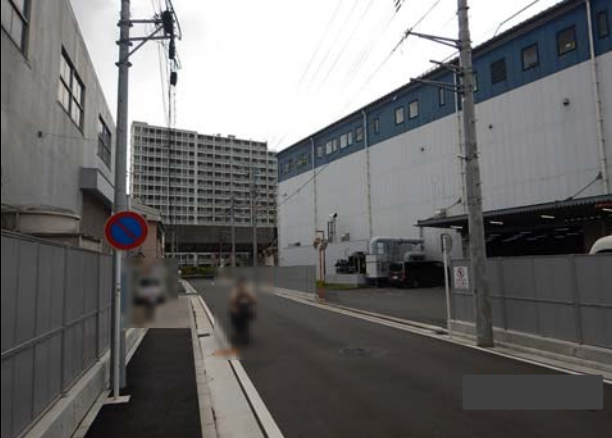
状況写真(実施後)
