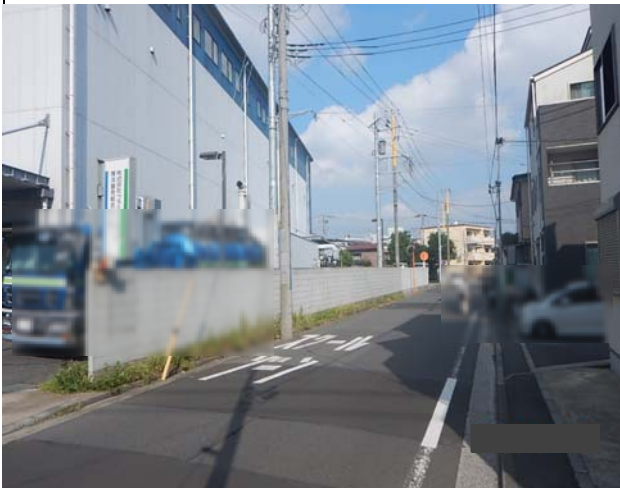
状況写真(実施前)
