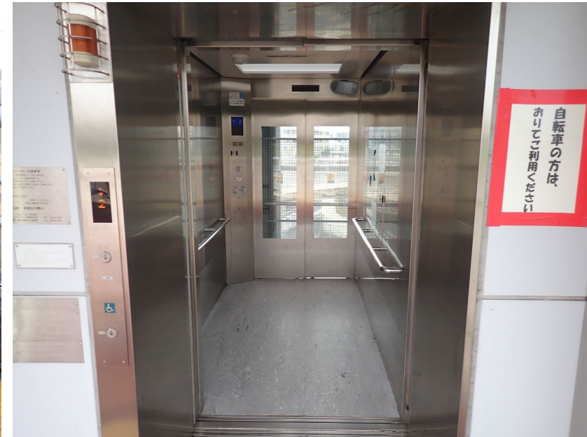
参考 幅1.5m 奥行2.5m (新横浜大橋)
