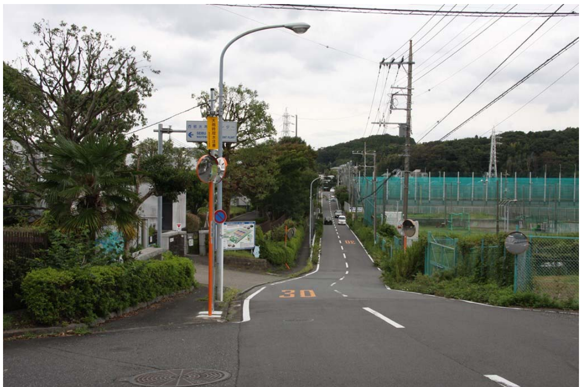
国道1号線側から
