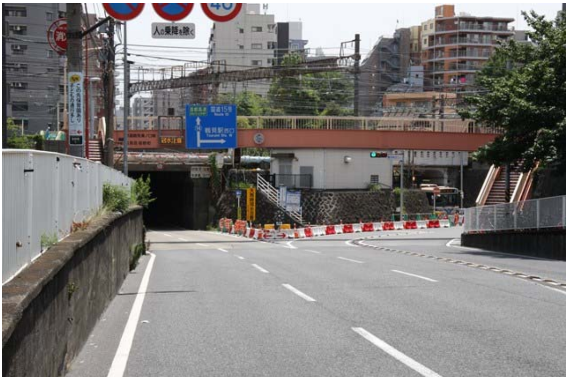
港北区方面側から
