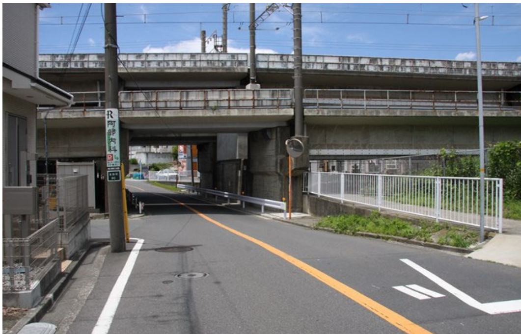
根岸線南側から
