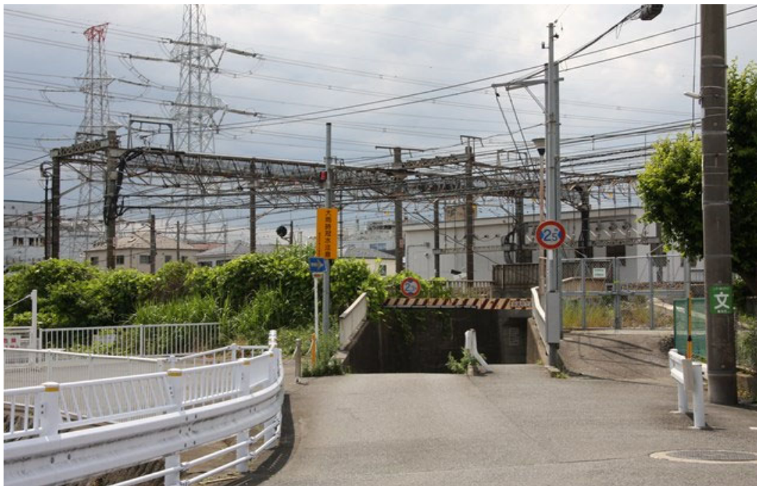
国道1号線側から
