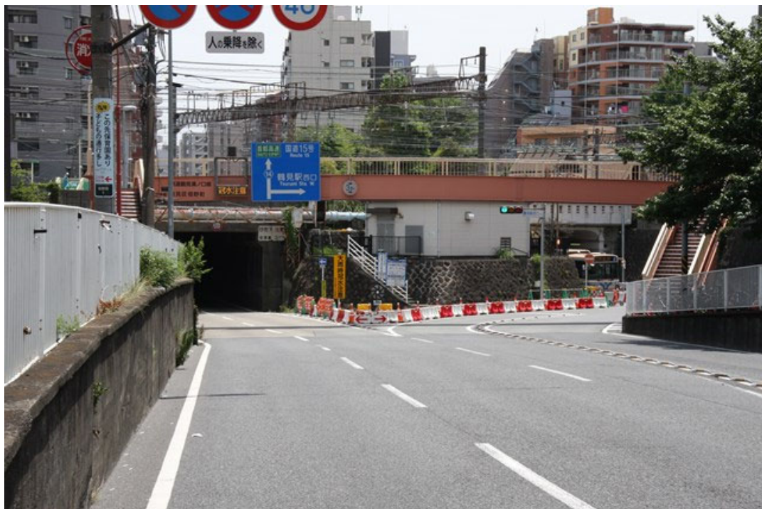
港北区方面側から
