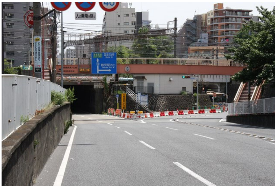
港北区方面側から
