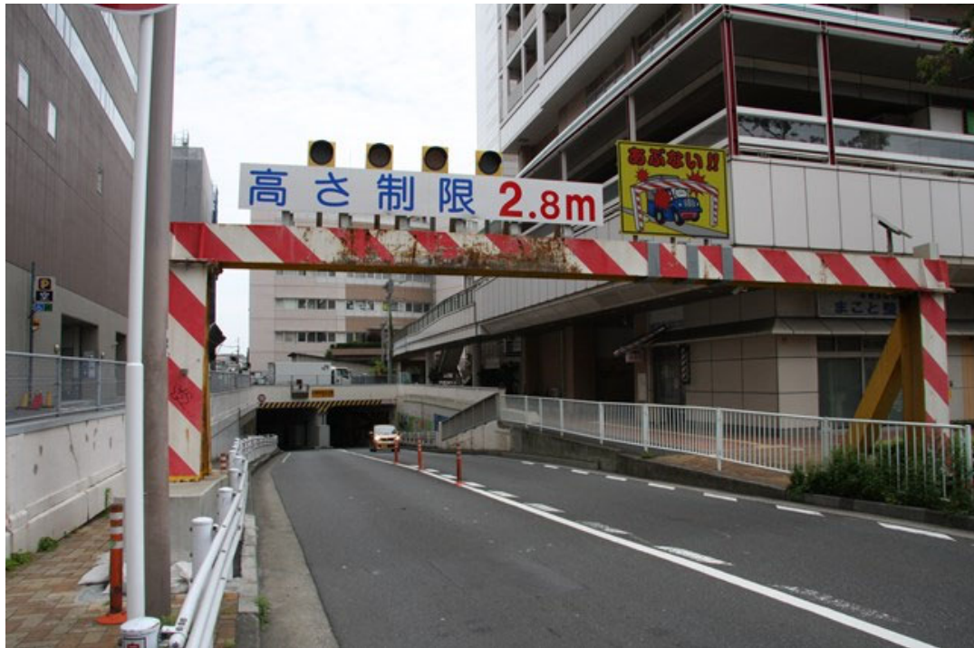
京急線側から
