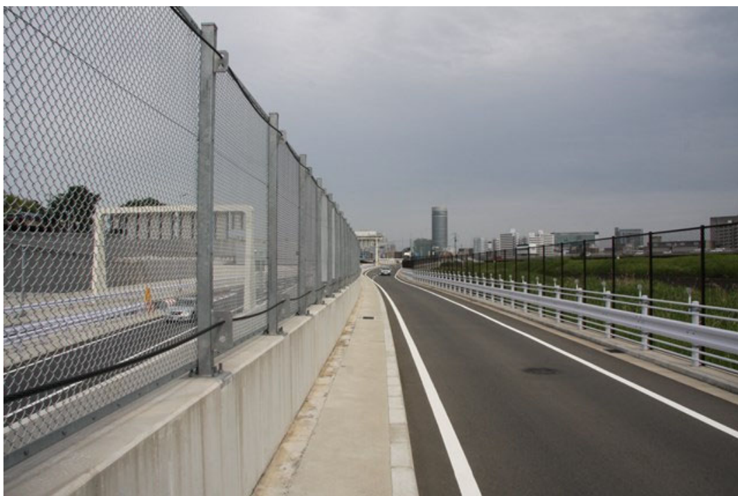
鶴見川上流側から
