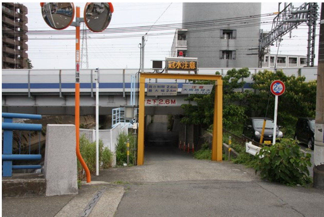
矢上川上流側から
