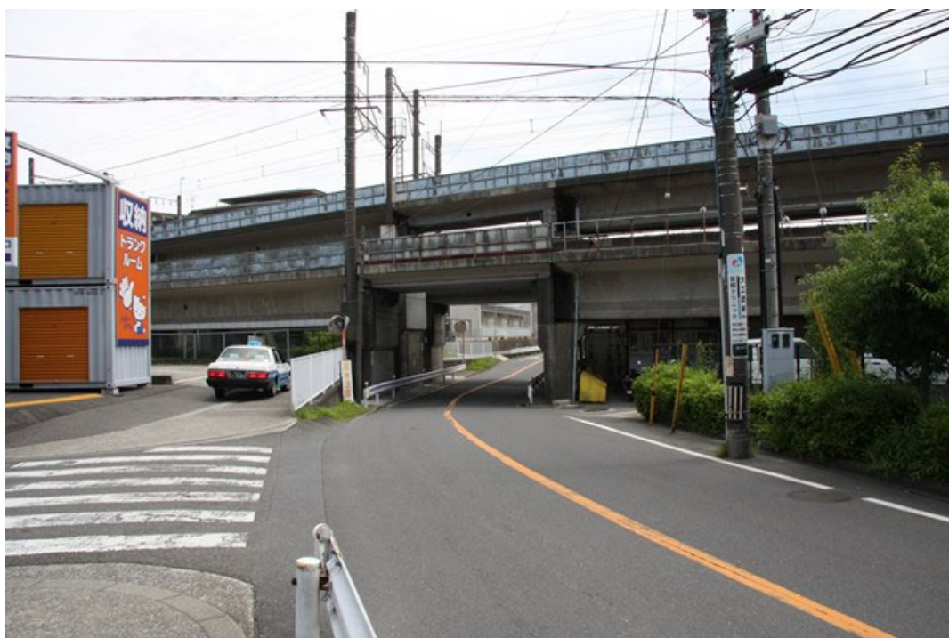
根岸線北側から
