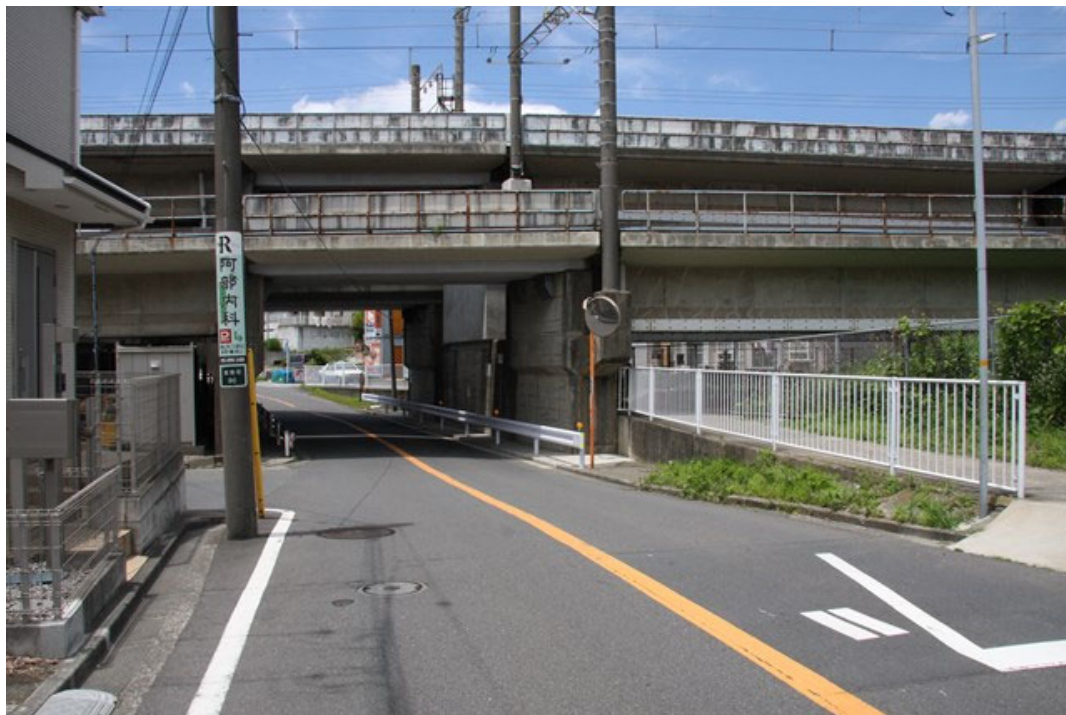
根岸線南側から
