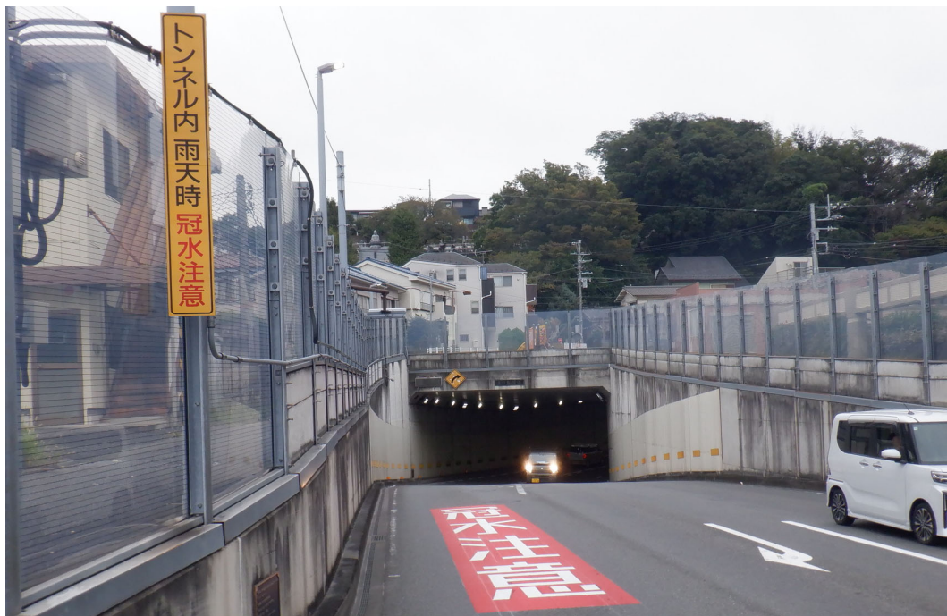
国道16号線側から
